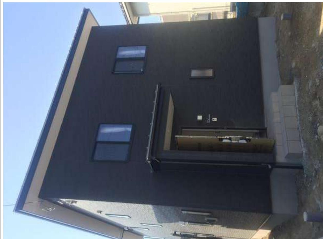
3-15 窯業系サイディング張りの取り付けは、目地通り良く、不陸、目違い等のないように行う。サイディングと土台水切り等の取り合いは、10mm程度の間隙をあける。(2/2)
