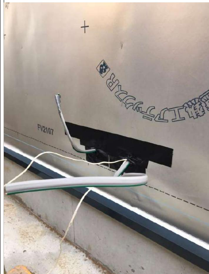
3-9口貫通部の防水措置を適切に処理する。一体成型品、または防水テープ処置
