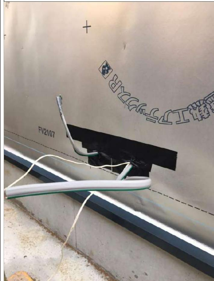
3-8 口土台水切り・雨押さえに防水シートを端部に密着させる。
