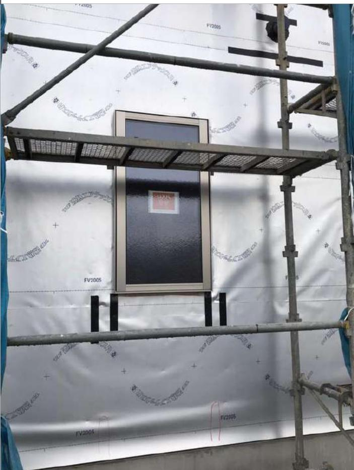
3-2口両面防水テープを用いて、サッシくぎ打ちフィンの根元を十分に覆い、縦・横の防水テープ交差部にすき間が生じないように張る。
